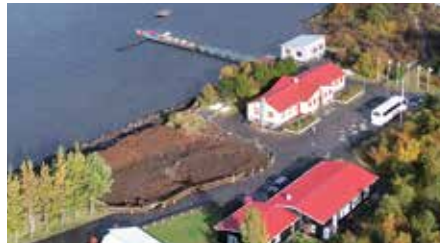
Þessi mynd sýnir vel hvar nýi matskálinn mun rísa.
