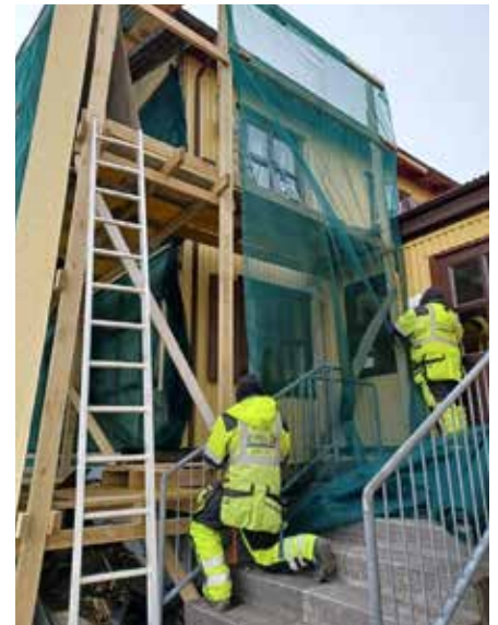
Vegna rakaskemmda hófst vinna við að endurbyggja útveggina á austurhlíð gamla skála.
