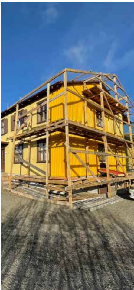
Í sumar hafa útveggir á suðurgafli á gamla skálanum í Vindáshlíð verið endurnýjaðir.
