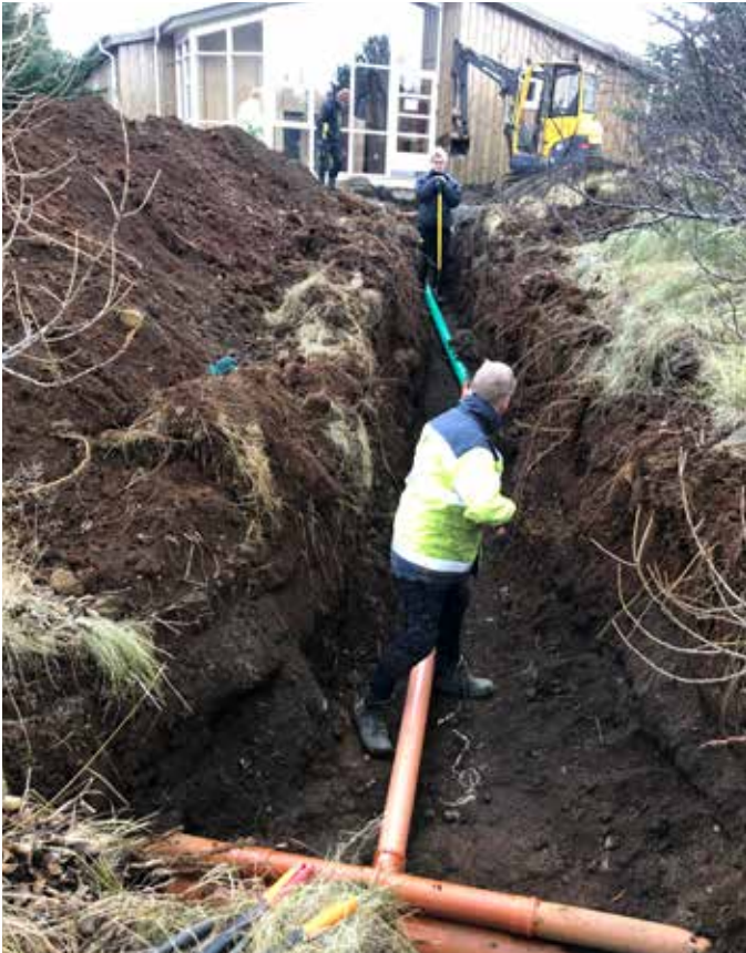
Unnið að breytingu að frárennislögnum við Birkiskála.
