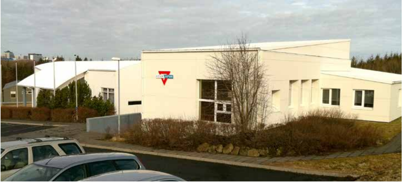
Eldra húsið í höfuðstöðvum félagsins á Holtavegi 28 er ónýtt vegna myglu. Húsið er 540 fm og fasteignamat þess er 235.100.000 kr. Ljóst er að rífa þarf húsið, en það verður gert þegar búið er að ákveða hvað verði byggt í staðinn og hvernig það skuli fjármagnað. Það eitt að rífa ónýta húsið má ætla að kosti nálægt 10 milljónum kr.
