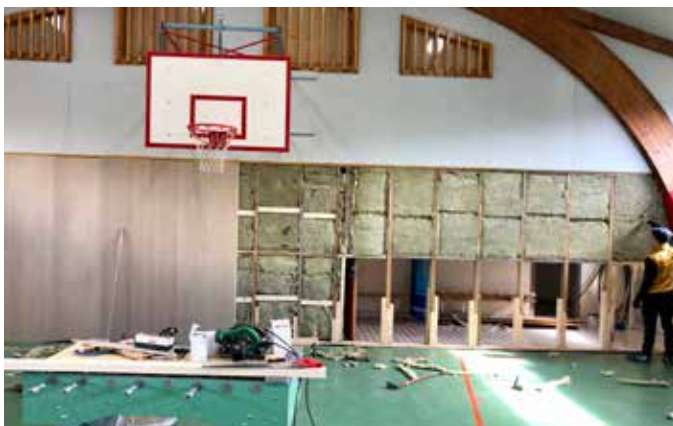
Vatnstjón skemmdi vegg í íþróttahúsinu, sem var að sjálfsgöðu lagaður.
